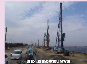
液状化対策の実施状況写真
