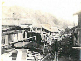
津波の被害(牟岐町東部)
