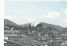
津波で壊された石巻ダンク
