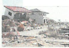
住家被害(仙台市若林区豊浜地区)
