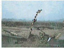
管線橋が折れ魚が川筋路が流された跡切
