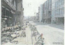
気仙沼市内の津波被害の痕跡
