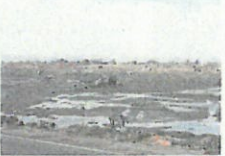
海浜村近から1km付近の津波被害の様子と駅前車両
