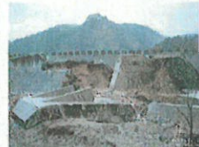
沖波で破壊された防雨堤
