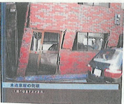
木造家屋の倒壊 ・比較的古い木造家屋で、両下階が崩壊しているのが目立つ。 ・隣のRC(鉄筋コンクリート造)が倒壊せずに残存しているが、瓦葺による被害も多く見られる。このタイプの建物は、地震被害が大きい。
