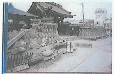
お寺の被災 (No.1) ・土壁の崩壊。 ・間接ブロックに高い構造だが、上部で固定がゆるむための崩壊。
