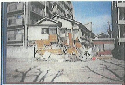
木造家屋の倒壊 ・比較的古い木造家屋で、両下階が崩壊しているのが目立つ。 ・隣のRC(鉄筋コンクリート造)が倒壊せずに残存しているが、瓦葺による被害も多く見られる。このタイプの建物は、地震被害が大きい。
