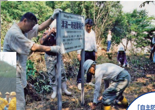
避難路の整備 (鳴門市)
