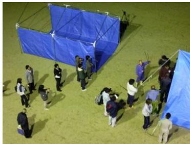
仮設テントの設営
