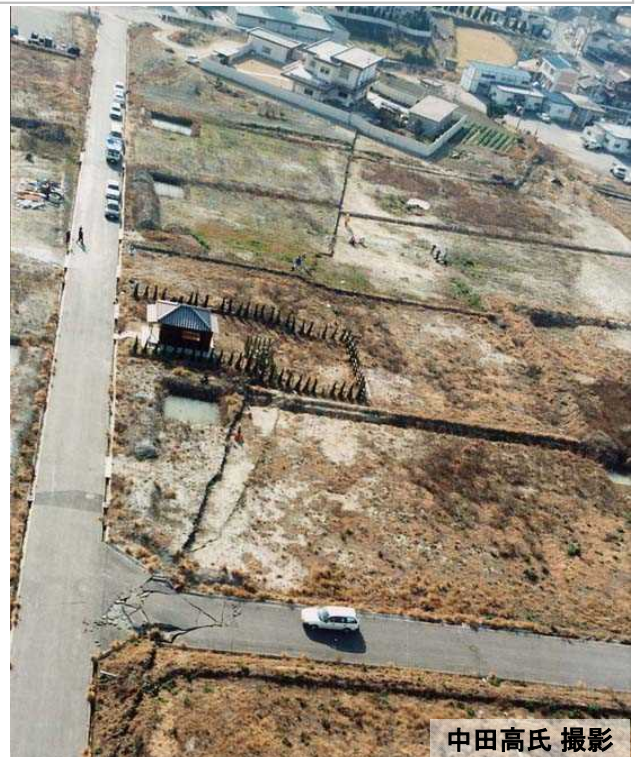
野島断層の変位による被害
