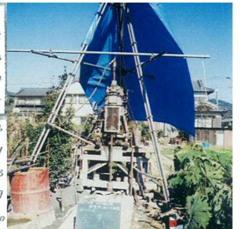
ボーリング作業状況
