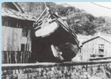
津波によって打ち上げられた船(昭和南海地震 旧海南町)
