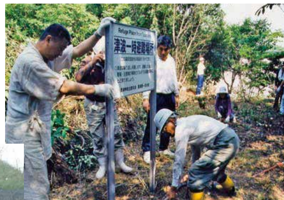
避難路の整備 (鳴門市)
